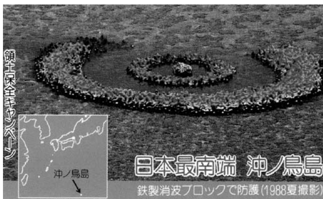
写真-1鉄製消波ブロックで露岩(多分北露岩)を保全作業中(1988年夏):コンクリート注入前(NTTテレカより:NTT許可済)
